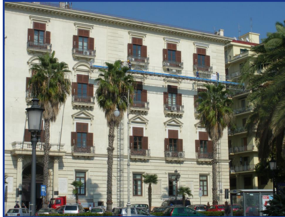
Ponteggi elettrici bicolonna max largh. 30 mt
