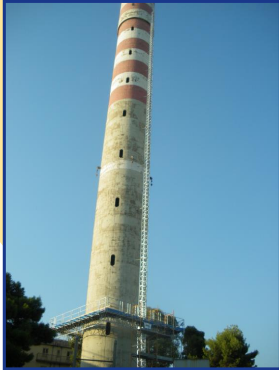
Ponteggi Elettrici per lavori particolari
