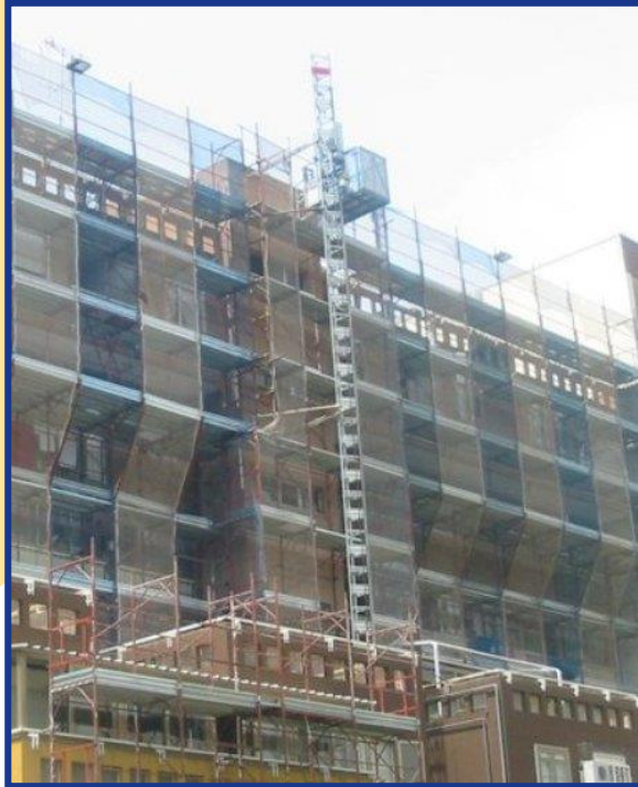
Montacarichi e Ponteggi fissi
